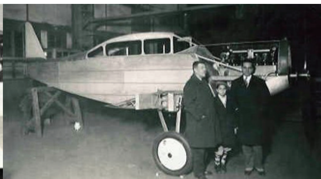
Em Paris, na empresa Caudron, o general Machado Vieira, à esquerda, chefe da Missão Militar Brasileira, visita a construção do M5, acompanhado por Guedes Muniz Fonte: Arquivo Guedes Muniz
