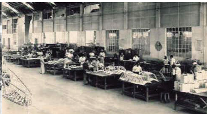
Fábrica do Galeão. À esquerda, na foto, a estrutura de tubos de aço soldados de um aparelho 3FG. Fonte: Museu Aeroespacial do Rio de Janeiro
